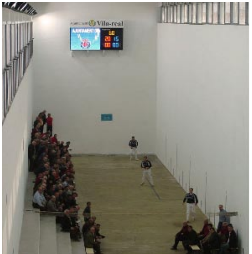
Instalación conjunta de marcador y pantalla en el trinquete de Vila-real. El conjunto está montado sobre la pared del trinquete a más de 7 metros de altura. Las dimensiones aproximadas son 4 metros de largo por 2 metros de alto.
